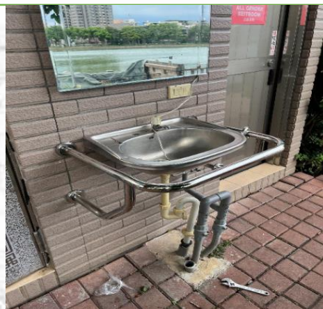
增設安全設施-廁所安全扶手
